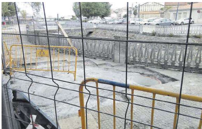
Obras del colector de la Alameda de Aldán en 2016. | Gonzalo Núñez
